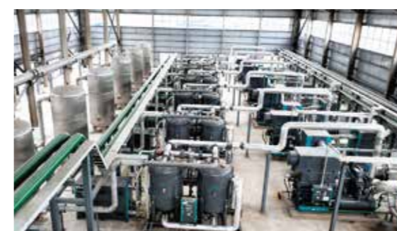
ЕРС к компрессорной станции
